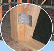
ビス止め 筋かい金具 (筋かいと柱の接合)
