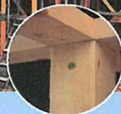
ドリフトピン接合 (柱と梁の接合)
